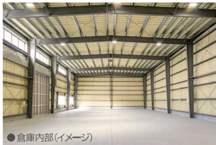
● 倉庫内部(イメージ)
