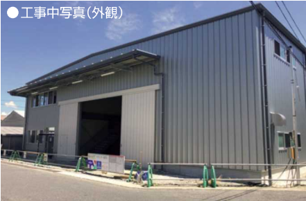
● 工事中写真(外観)
